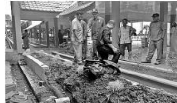
ANGGOTA DPRK Nagan Raya meninjau lokasi nahanya rubuh akibat tergenang air di RSUD SIM, Senin (2/12).
